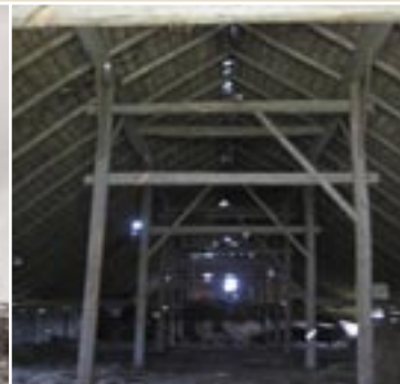
Pėdinė kluono konstrukcija
