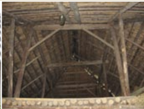
Pėdinė stogo konstrukcija
