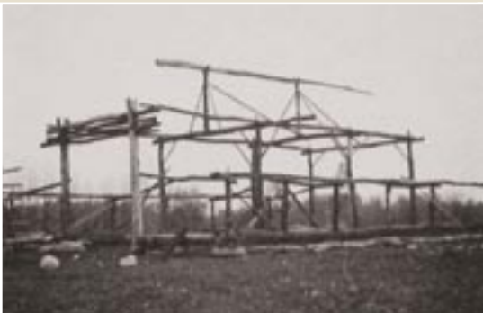
Kluono pėdinė konstrukcija
