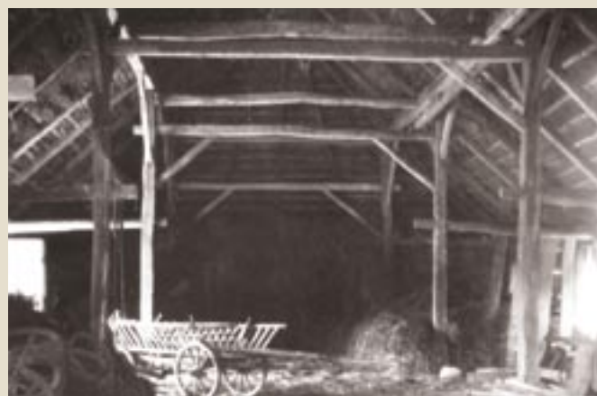
Pėdinė permetinė kluono stogo konstrukcija Okainių k. Šėtos vls. Kėdainių aps. (LLM, 475 pav.)
